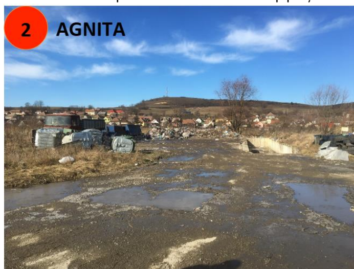
Figură 2-10 - Stația de transfer Agnita
