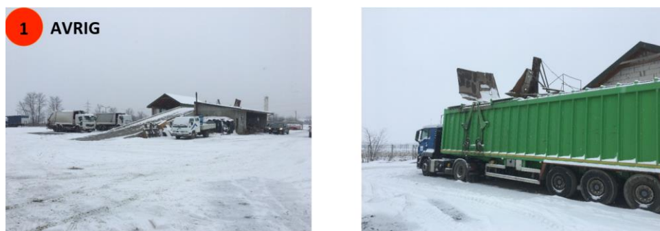
Figură 2-8 - Stația de transfer și compostare Avrig
