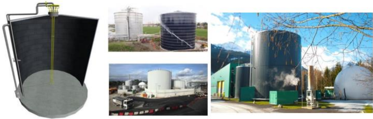
Figură 3-66 Exemple de digestoare verticale în lichid
