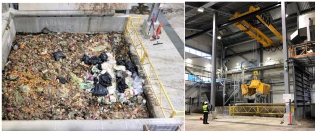
Figură 3-63 Groapa tehnologică de stocare și podul rulant cu greifer
