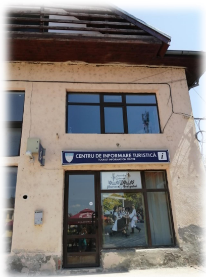
Foto nr. 26 – Centrul de informare turistică Avrig
